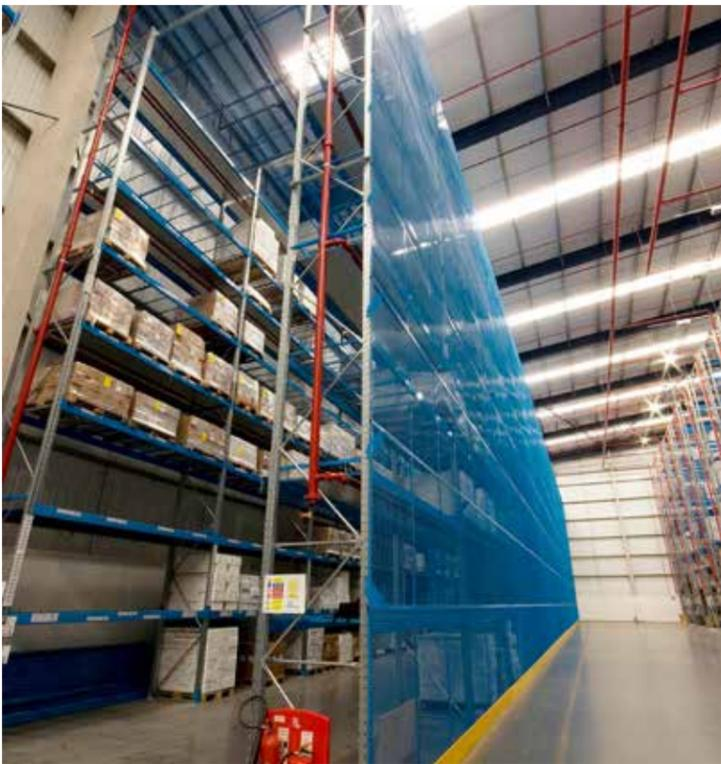
Protection anti-chute SafeStore livrée avec consoles spéciales et coloris hors standard.
